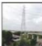
Rangka menara listrik tegangan tinggi (SUTET)
