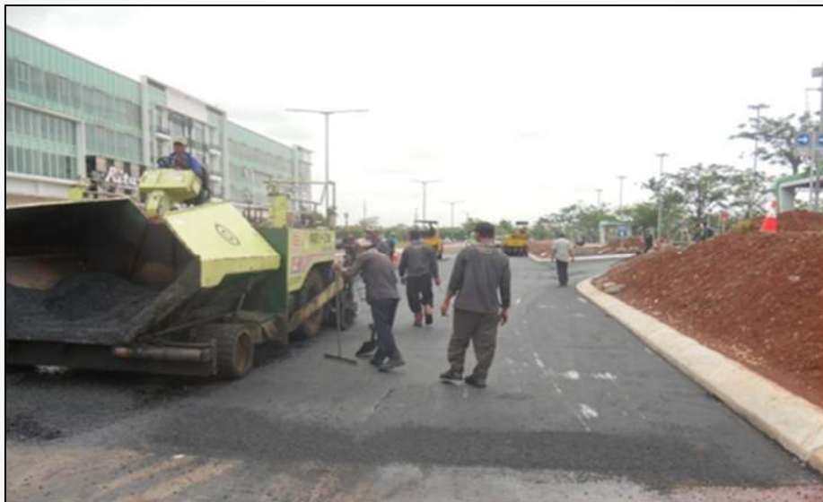
Gambar 1. Proses Perkerasan Jalan Lentur di Sektor Scientia Summarecon Serpong (Sumber : Summarecon, 2017)
