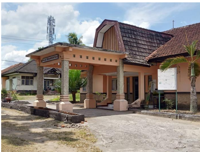
Gambar 3: Tampak depan Bapelkes Provinsi NTB di Jl. Gora 2 Selagalas, Kota Mataram.
